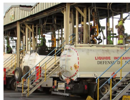
Déchargement des produits au dépôt de LPSA
